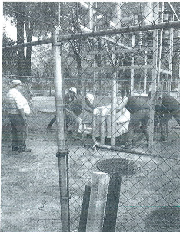
Desinstalación de transformador para realizar maniobras con grúa para su extracción
