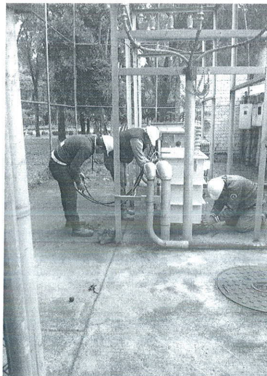
Aislamiento de luz, baja de cuchillas y medidas de seguridad para retirar el transformador en uso.
