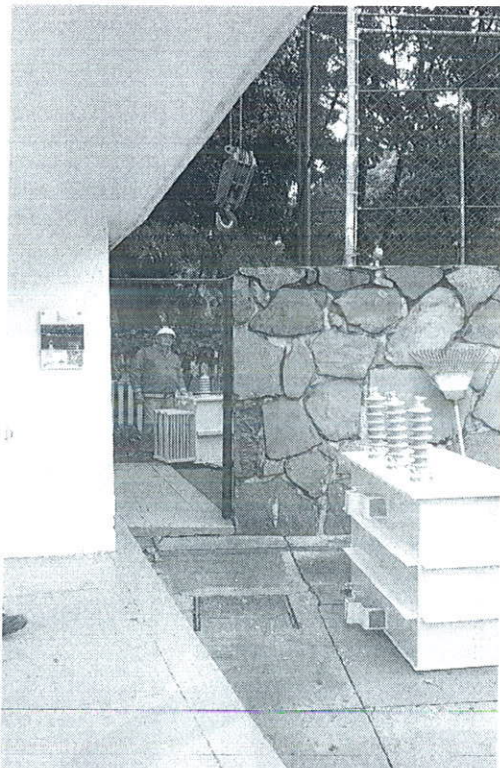
Preparación y maniobras con grúa del transformador de 150KVA para ser sustituido por el transformador reparado.
