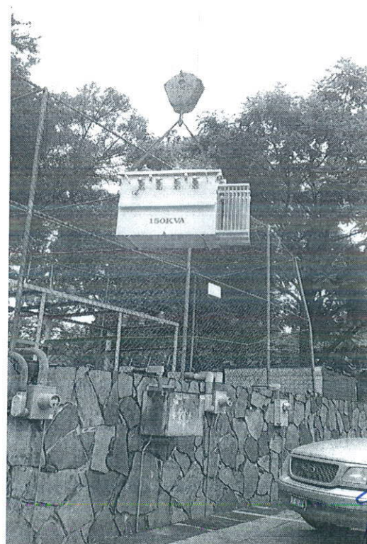
Preparación y maniobras con grúa del transformador de 150KVA para ser sustituido por el transformador reparado.
