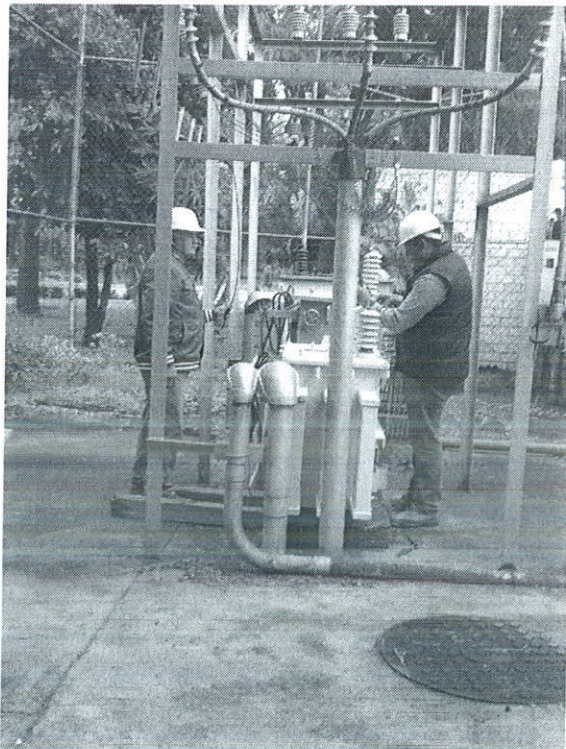
Aislamiento de luz, baja de cuchillas y medidas de seguridad para retirar el transformador en uso.
