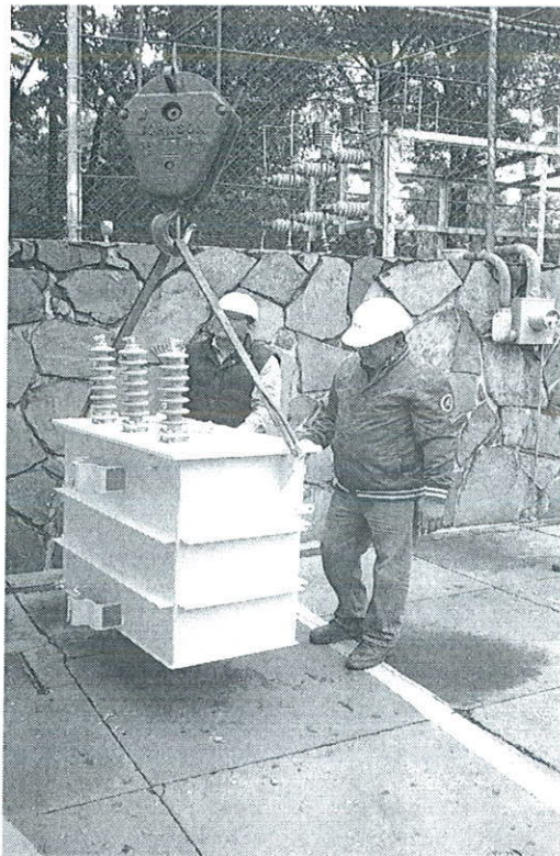
Maniobras e instalación de transformador reparado de 112.5 KVA del IAJ
