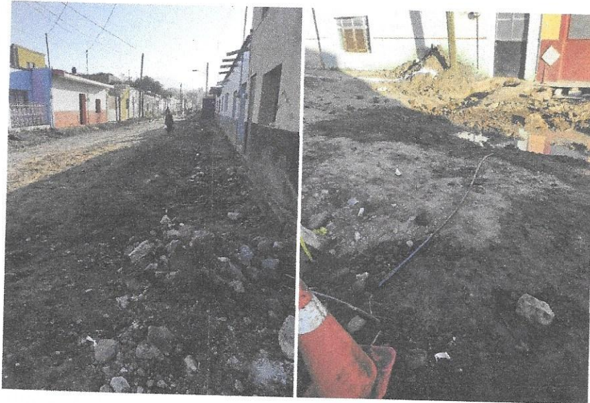
Se adoquinó la calle independencia y se puso toma de drenaje y red de Agua Potable.
