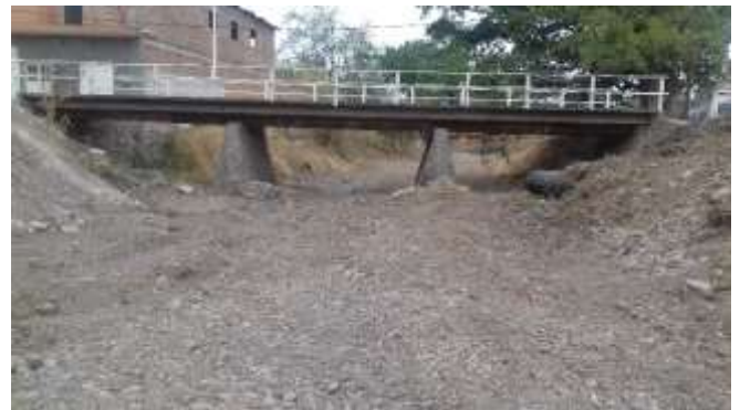
LIMPIEZA DE RIOS Y ARROYOS
