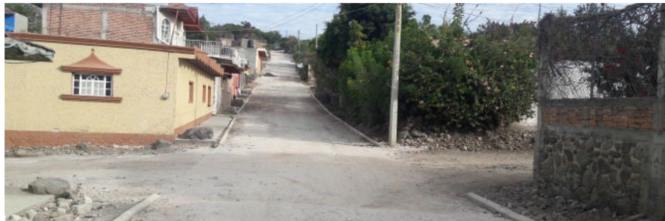
Rehabilitación de línea de agua potable, empedrado tradicional y drenaje en la calle Francisco Villa en la localidad de Villa Emiliano Zapata.
