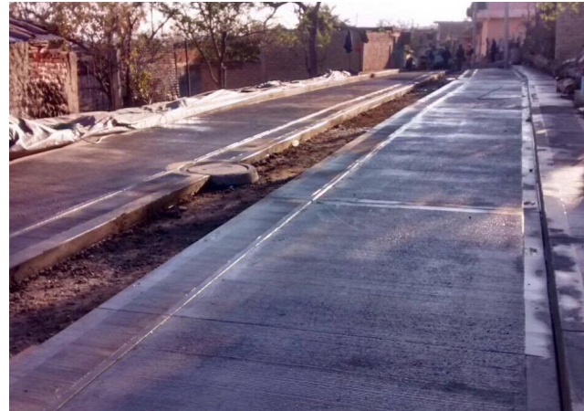
Construcción de pavimento de concreto hidráulico en la calle Melchor Ocampo en la localidad de El Volantín municipio de Tizapán el Alto, Jalisco.
