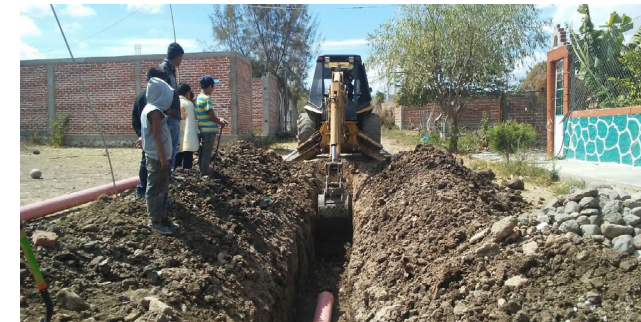
Red de agua potable en la Col. San José.
