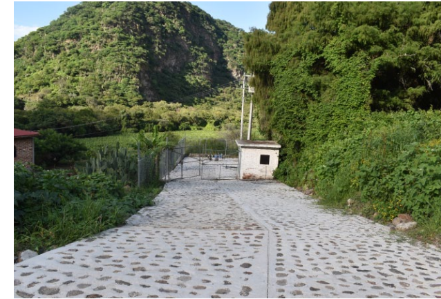
Equipamiento de pozo profundo de La Cañada, en el municipio de Tizapán el Alto, Jalisco.
