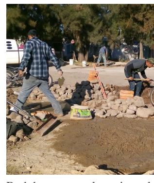
Red de agua en el camino a la ordeña col. Lázaro Cárdenas.
