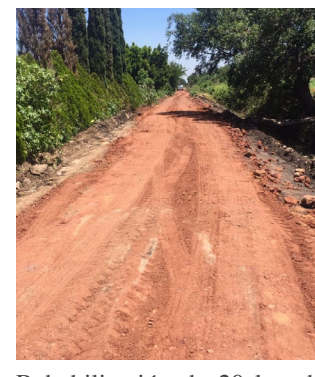
Rehabilitación de 20 km de caminos saca cosechas.
