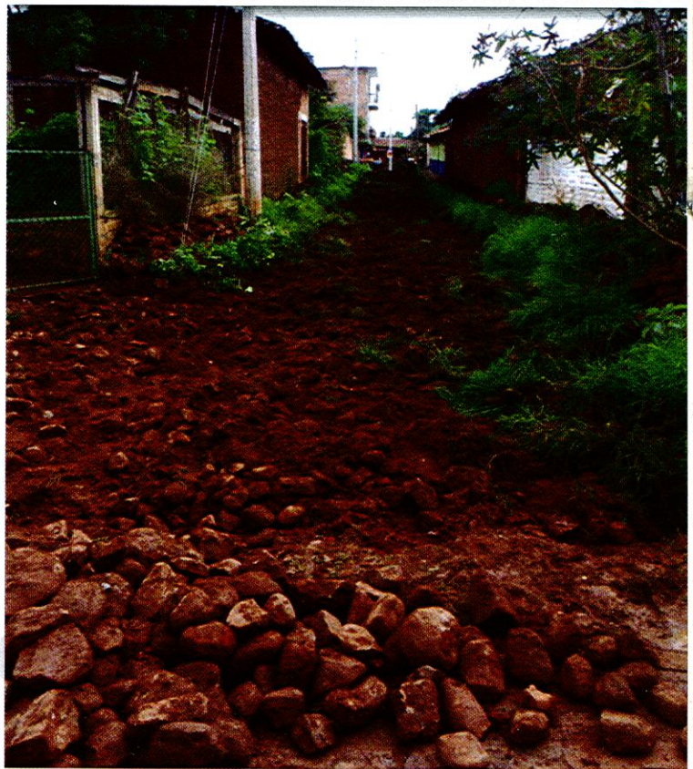
EMPEDRADO AHOGADO EN CONCRETO Y RED DE AGUA POTABLE Y ALCANTARILLADO EN CALLE EMILIANO ZAPATA EN CABECERA MUNICIPAL
