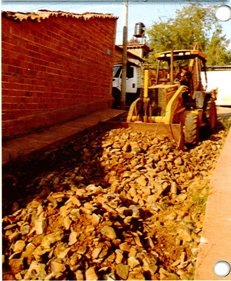
EMPEDRADO AHOGADO EN CONCRETO, RED DE AGUA POTABLE Y ALCANTARILLADO EN CALLE MARIANO JIMENEZ EN CABECERA MUNICIPAL
