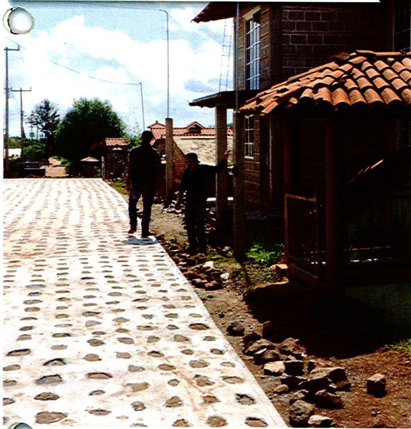
EMPEDRADO AHOGADO EN CONCRETO EN CALLE DE LA COMUNIDAD DE "LAS CUEVAS"
