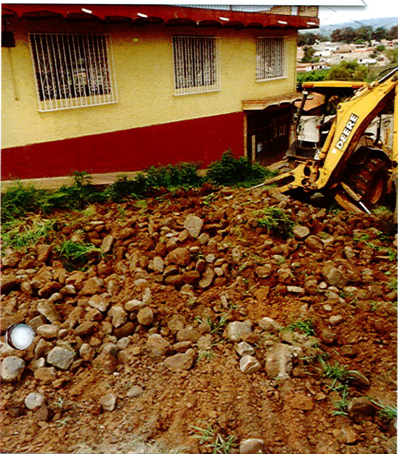
EMPEDRADO AHOGADO EN CONCRETO Y RED DE AGUA POTABLE Y ALCANTARILLADO EN CALLE PLUTARCO ELIAS CALLES EN CABECERA MUNICIPAL
