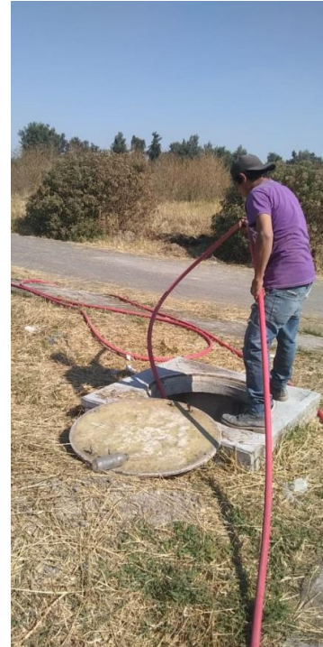
Colocación de cable XLP CAL 1/0.
