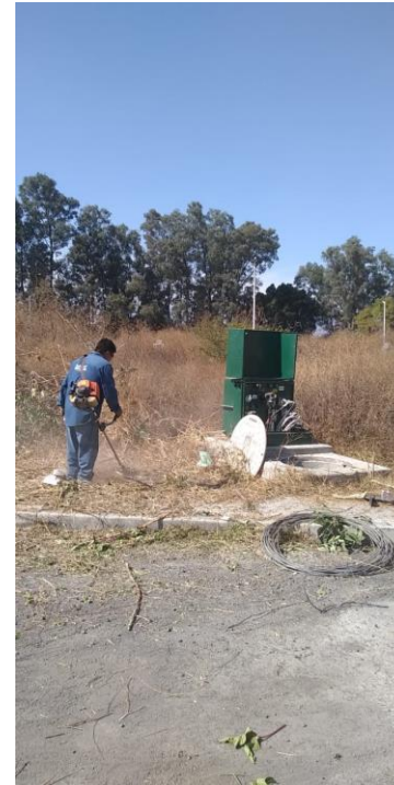
Limpieza y deshierbe de área de banqueta y lote.
