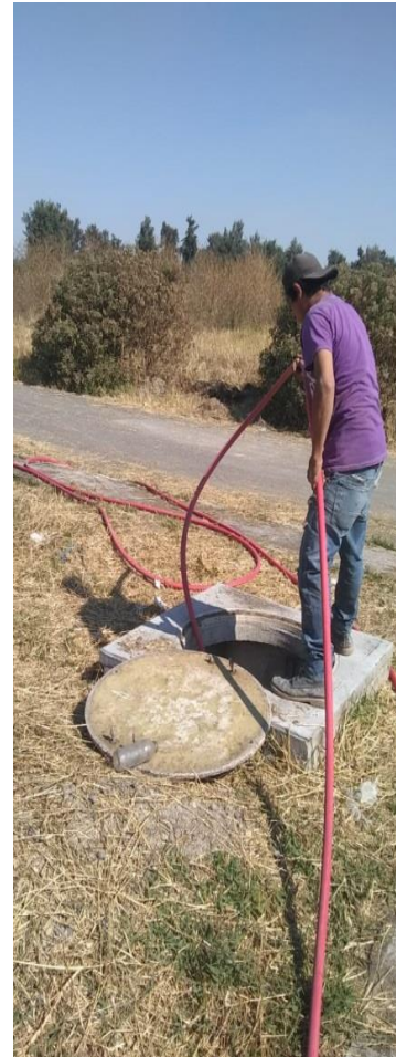
Colocación de cable XLP CAL 1/0.
