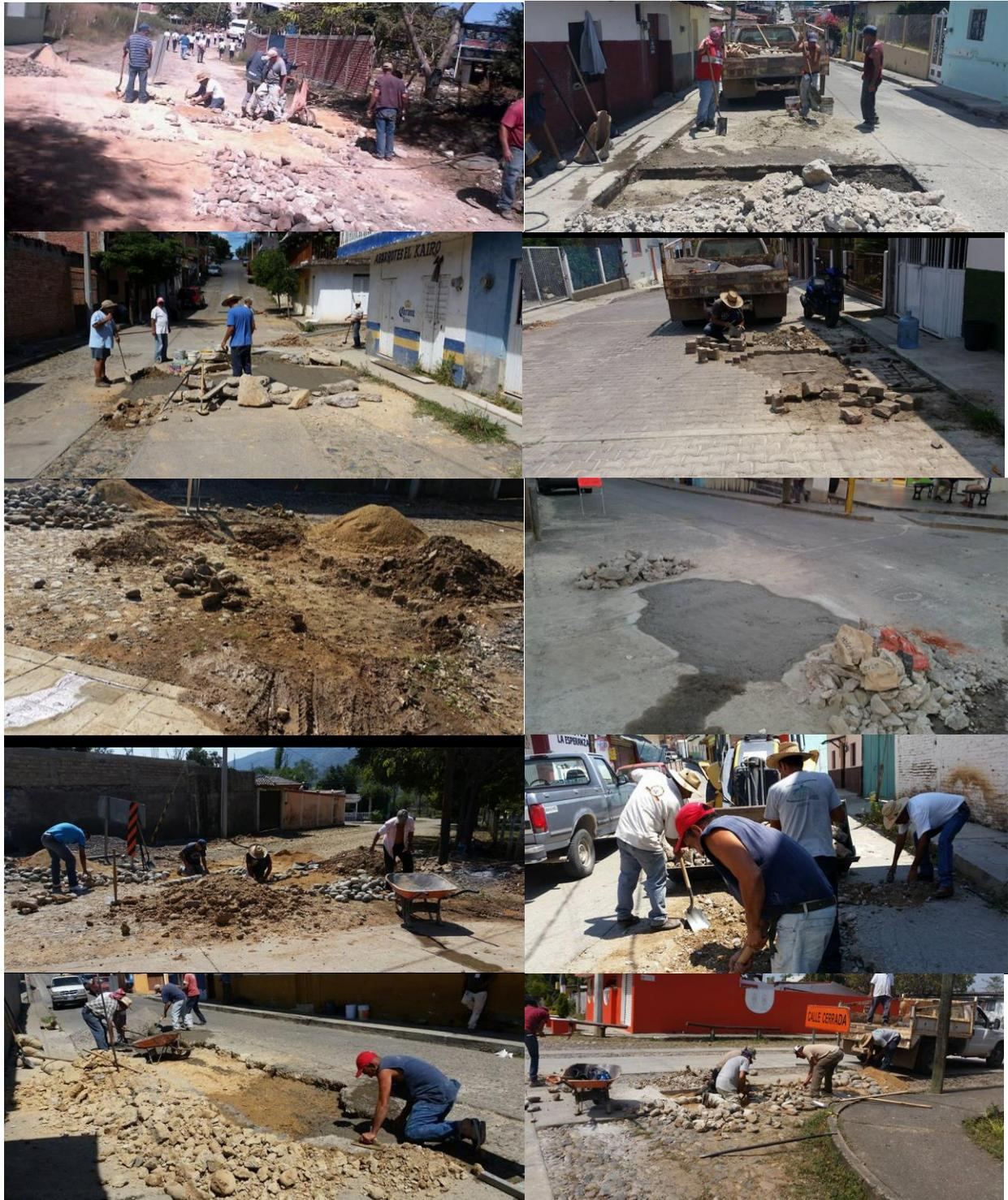
Reparación de línea de agua potable en La Suiza 17 tramos de tubo de 8 pulgadas con juntas ligas y tornillería.
