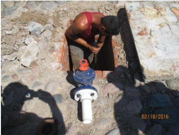
Colocación de cuatro válvulas de 3 pulgadas en el guayabo
