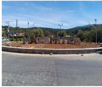
Construcción de glorieta en la localidad de La Estacada
