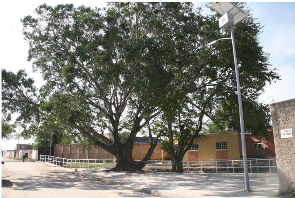
Terminada la ampliación de la calle 20 de Noviembre, puente, alumbrado y protecciones en el Arroyo Santa Anita
