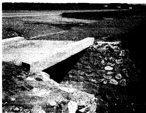
Foto 1.97 Terminación de los puentes.
