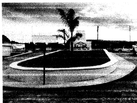
Foto 1.90 Terminación de la obra.
