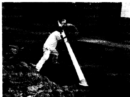
Foto 1.34 Alcantarillado en proceso constructivo.
