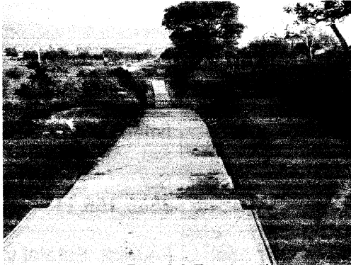
Foto 2.0 Terminación de la obra.
