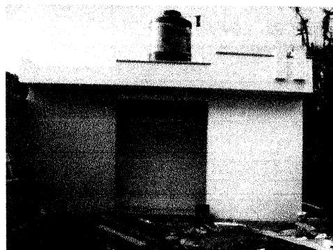
Foto 1.86 Proceso de Terminación.
