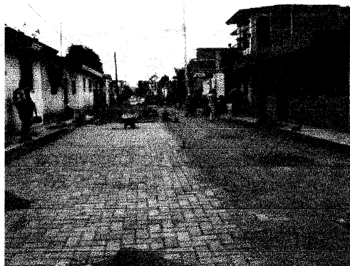
Foto 1.77 Terminación de la Obra.
