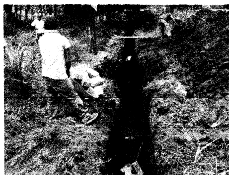
Foto 1.46 Alcantarillado en su proceso constructivo.
