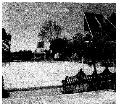
Foto 2.66 Rehabilitación de Canchas.
