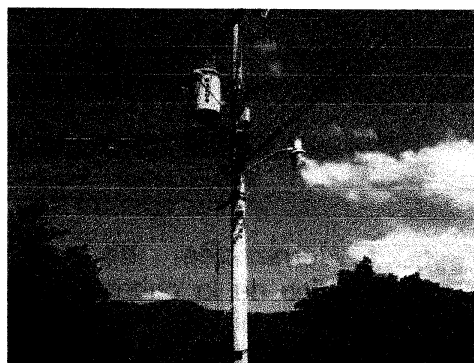
Foto 2.3 Cambio de Transformador.
