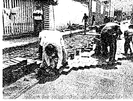
Colocación de adoquín en calle Allende.
