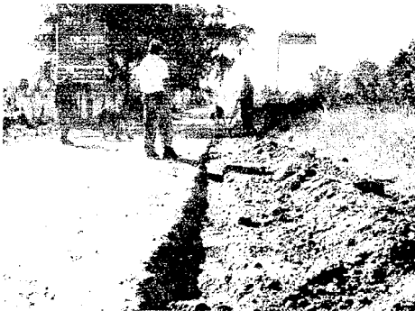
Proceso de construcción de andador.
