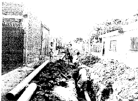
Proceso de instalación de tubería para red de alcantarillado en Calle Zaragoza.
