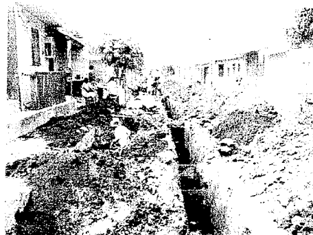
Proceso de instalación de tubería para alcantarillado en Calle Allende.
