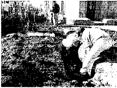
Reparación de red de agua potable.
