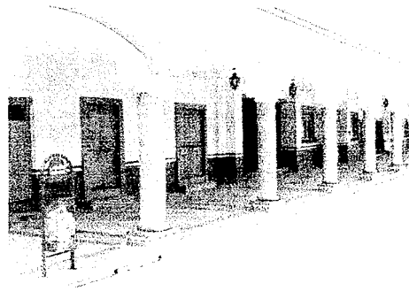
Aplicación de pintura en portales San Sebastián del Sur.
