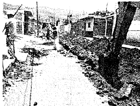
Inicio de obra: rehabilitación de red de agua potable en calle Guerrero.
