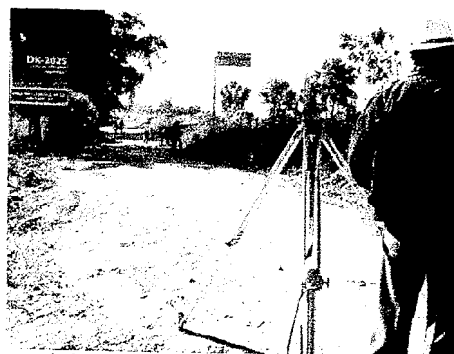
Inicio de obra: Trazo y nivelación
