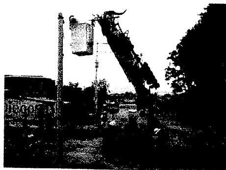
Trabajo en coordinación con Comisión Federal de Electricidad
