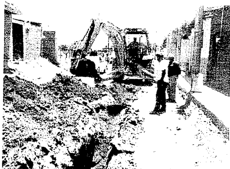
Excavación para obra: rehabilitación de red de alcantarillado en calle Guerrero.
