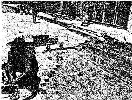
Inicio de obra Adoquinamiento en calle Francisco I. Madero.
