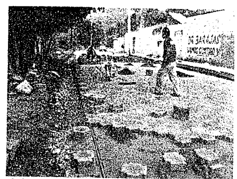
Inicio de obra Adoquinamiento en calle Guerrero.
