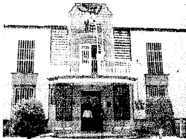
Colocación de la decoración luminosa de la Presidencia municipal para los festejos patrios.
