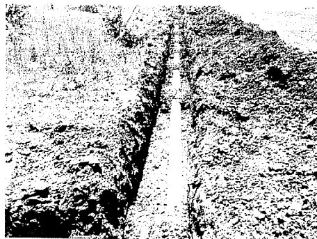
Colocación de tubería línea de conducción de agua potable
