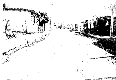
Terminación de alcantarillado en calle Francisco I. Madero.
