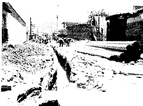
Proceso de instalación de tubería para alcantarillado en Calle Guerrero.
