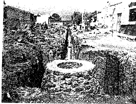
Construcción de registros en calle Abasolo. San Andrés Ixtlán.
