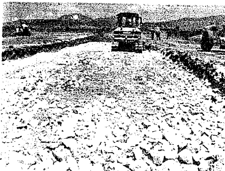
Filtro en plataformas
