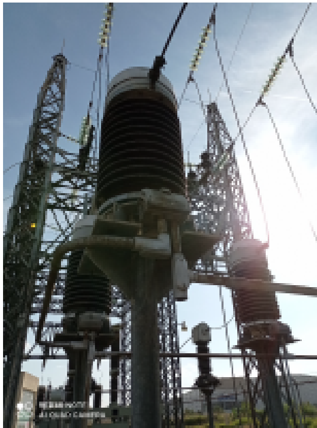
Transformadores de voltaje
