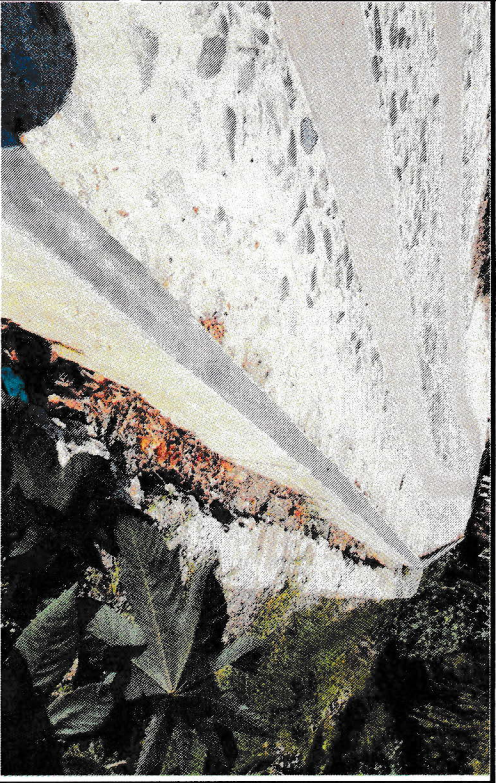
GUARNICION CON UNA SECCION TRAPEZOIDAL DE 15CM DE BASE MAYOR, 12 CM DE BASE MENOR Y 50 CM DE ALTURA CON F.C= 200KG/CM2
