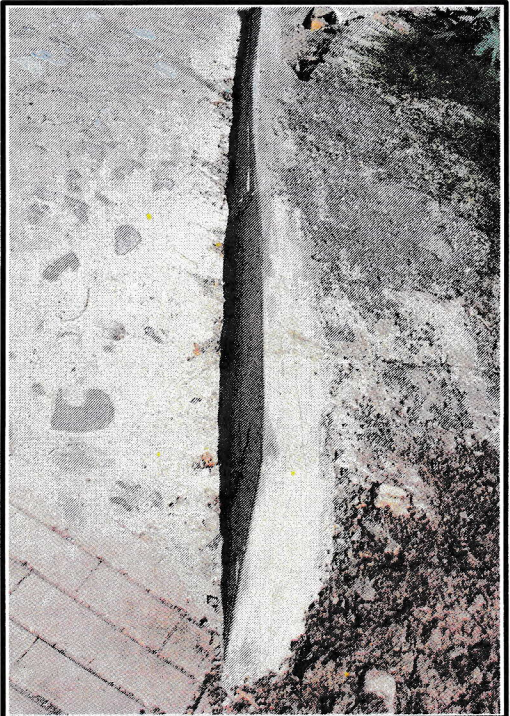
GUARNICION CON UNA SECCION TRAPEZOIDAL DE 15CM DE BASE MAYOR, 12 CM DE BASE MENOR Y 50 CM DE ALTURA CON F.C= 200KG/CM2
