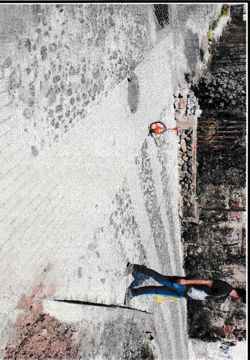
GUARNICION CON UNA SECCION TRAPEZOIDAL DE 15CM DE BASE MAYOR, 12 CM DE BASE MENOR Y 50 CM DE ALTURA CON F.C= 200KG/CM2
