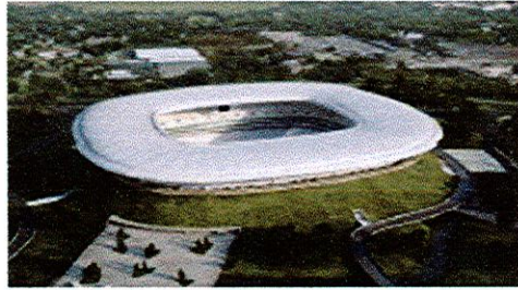
Estadio Omnilife: Red Eléctrica Media y Baja Tensión.
