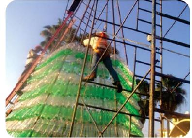
Para la realización del Árbol Navideño Ecológico se utilizó una estructura de metal en forma de Triángulo hexagonal con una altura de 10 metros, utilizando un aproximado de 4,500 cuatro mil quinientas botellas de PET.
