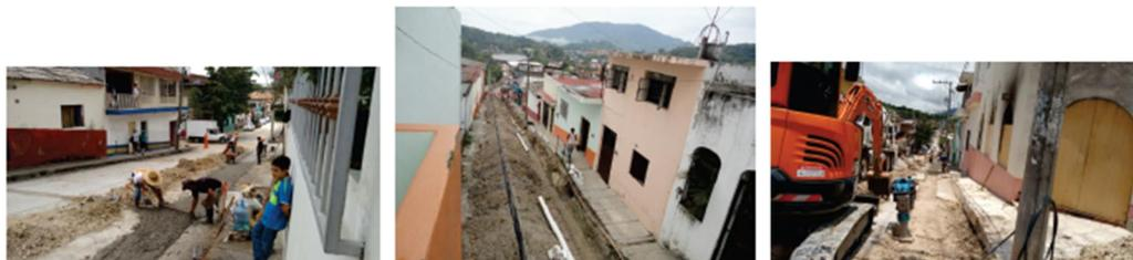
Rehabilitación y sustitución de línea de asbesto cemento de 2 ½ " y 4" de diámetro del circuito en la Cabecera Municipal (1ra. Etapa)
