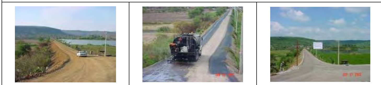
Foto 1.14 Pavimentación del ingreso carretero a San Agustín.
