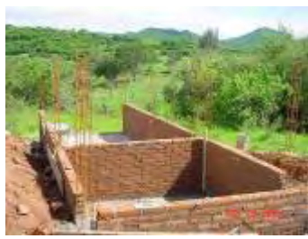
Foto 1.19 Construcción de fosa séptica en La Alpatahua
