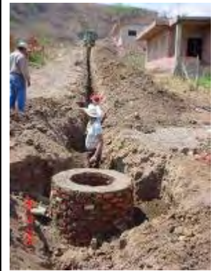
Foto 1.22 Ampliación de red de drenaje en colonia Guadalupeana
