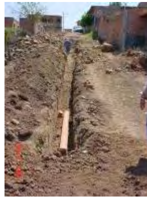
Foto 1.22 Ampliación de red de drenaje en colonia Guadalupeana
