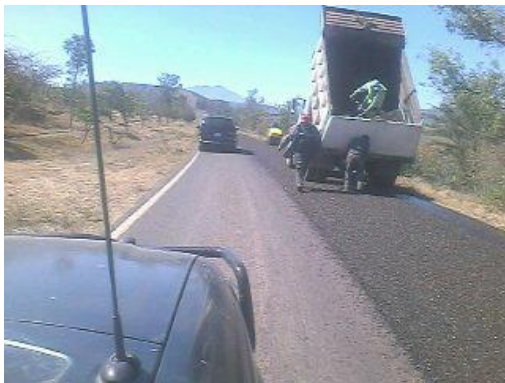
Reencarpetamiento de asfalto Carretera de San Juanito de Esc.
