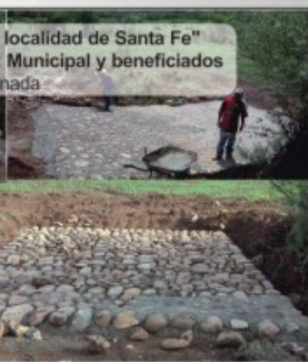
"Construcción de vado en camino real Manzanillito - San Clemente" Localidad: Manzanillito- San Clemente Aportación: Municipal (Materiales) y SCT (mano de obra) Obra Terminada
