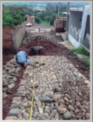
"Construcción de empedrado en calle Guadalajara" Localidad: Cabecera Municipal Avance físico a la fecha 414.44 m2 Aportación: Municipal y beneficiados Obra en proceso
