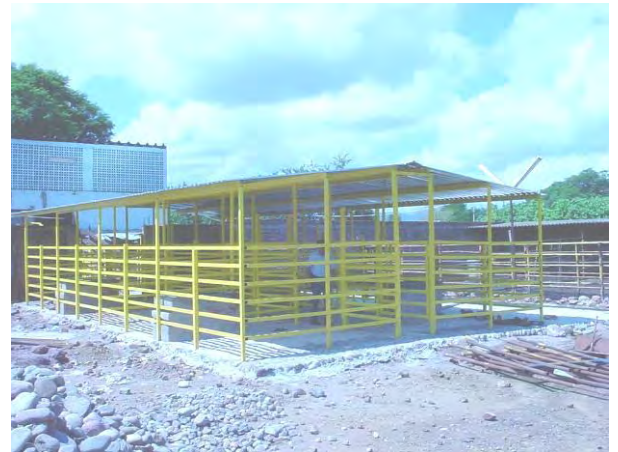
Construcción de Corraletas en el Rastro Municipal
