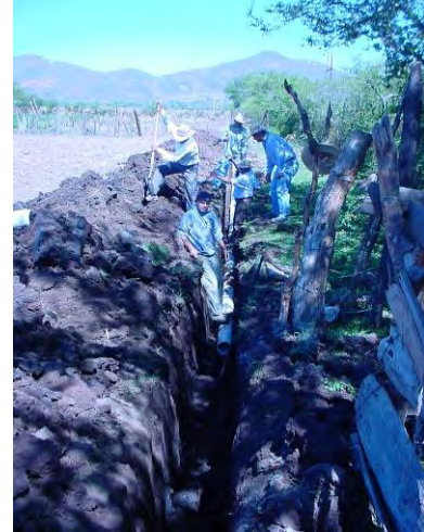
Línea de conducción, tanque col. Guadalupeana
