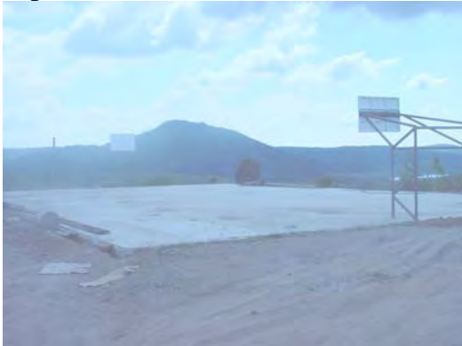
Construcción de Canchas de Usos Múltiples en las comunidades
