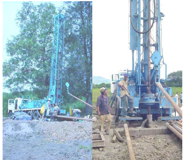
Perforación de pozo profundo en La Taberna y San Clemente
