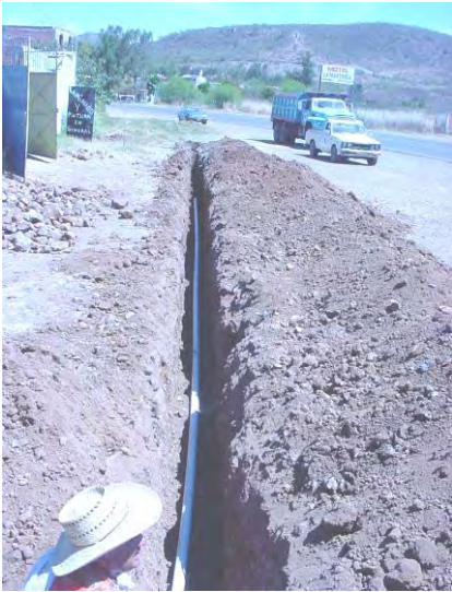
Misma obra, 160 mts. Lineales (H. Ayuntamiento)
