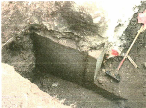
f).- RELLENO COMPACTADO A MANO CON MATERIAL PRODUCTO DE LA EXCAVACIÓN EN ZAPATA # 28, 4 Y 5
