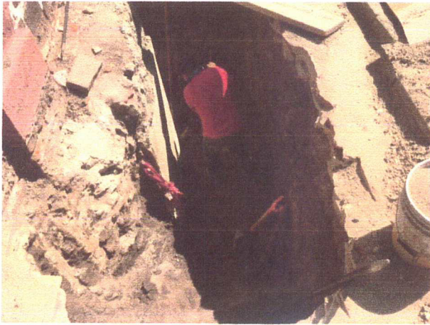
f).- RELLENO COMPACTADO A MANO CON MATERIAL PRODUCTO DE LA EXCAVACIÓN EN ZAPATA # 23, 24
