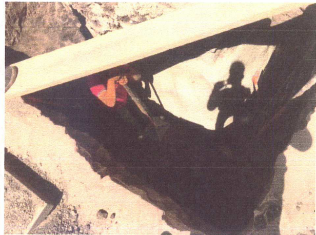
f).- RELLENO COMPACTADO A MANO CON MATERIAL PRODUCTO DE LA EXCAVACIÓN EN ZAPATA # 23, 24
