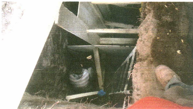
CIMBRA DE MADERA EN ZAPATA # 5 Y 4
