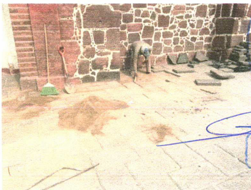
g).- COLOCACIÓN DE ADOQUIN EN ZAPATAS # 23, 24, 28, 29, 4 y 5
