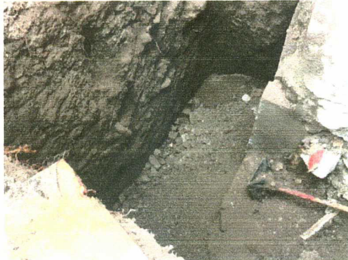
f).- RELLENO COMPACTADO A MANO CON MATERIAL PRODUCTO DE LA EXCAVACIÓN EN ZAPATA # 28, 4 Y 5
