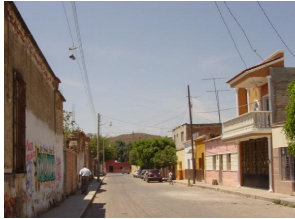
Foto 49. La imagen urbana de la calle 16 de Septiembre se ve afectada por la presencia de publicidad en la barda de los restos de la Ex-hacienda La Primavera.
