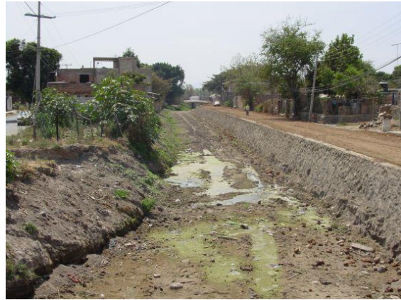
Foto 16. En la foto se puede observar el desazolve y retiro de maleza realizados recientemente en este tramo del cauce, como parte del proyecto de rescate de la zona federal.
