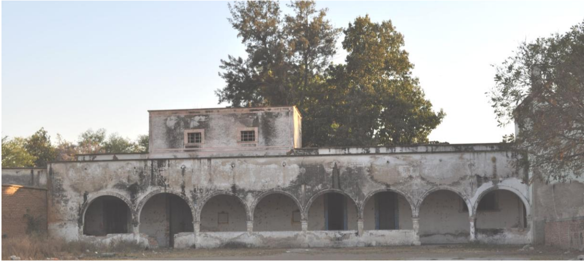
Foto 39. Vestigios de la casa grande de la Ex-hacienda La Parreña, de este edificio destaca el pórtico de ingreso sostenido por ocho arcos de medio punto.
