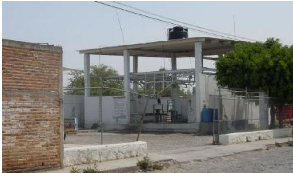
Foto 12. Instalaciones del Rastro Municipal. El manejo y sacrificio del ganado puede ser visto desde la calle por cualquier persona, se requiere hacer las adecuaciones necesarias para evitar esto, además de cumplir con las normas sanitarias de este tipo de equipamiento.
