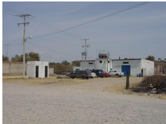
Foto 65. Fábrica de tequila ubicada por la calle Roberto Ruiz al oeste de la ciudad.
