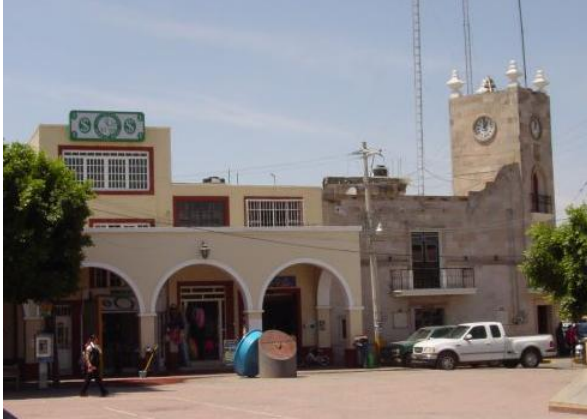
Foto 10. Edificio de la Presidencia Municipal y el portal de acceso al mercado y otros locales a un costado de la plaza principal.
