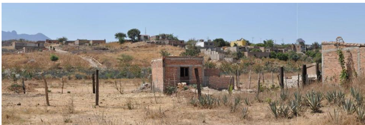
Foto 32. Colonia Pedro Moreno, asentamiento irregular que se está desarrollando en la ladera a un lado del camino a La Mesa. La ladera es considerada como zona de riesgo por la posibilidad de que ocurran deslizamientos de tierra.
