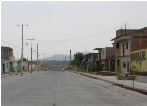
Foto 73. Av. Avelino Ruiz en su entronque con el Boulevard Lázaro Cárdenas. Este importante vial de acceso a la ciudad fue pavimentada recientemente con concreto, estando pendiente de realizar algunas adecuaciones como el movimiento de los postes de de la línea de energía eléctrica y el arbolado.
