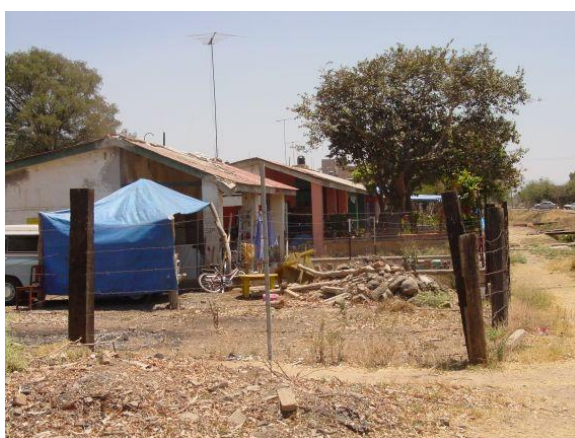
Foto 33. Construcciones irregulares invadiendo el derecho de vía del ferrocarril, y que es necesario reubicar para dar continuidad a la calle paralela a esta infraestructura.
