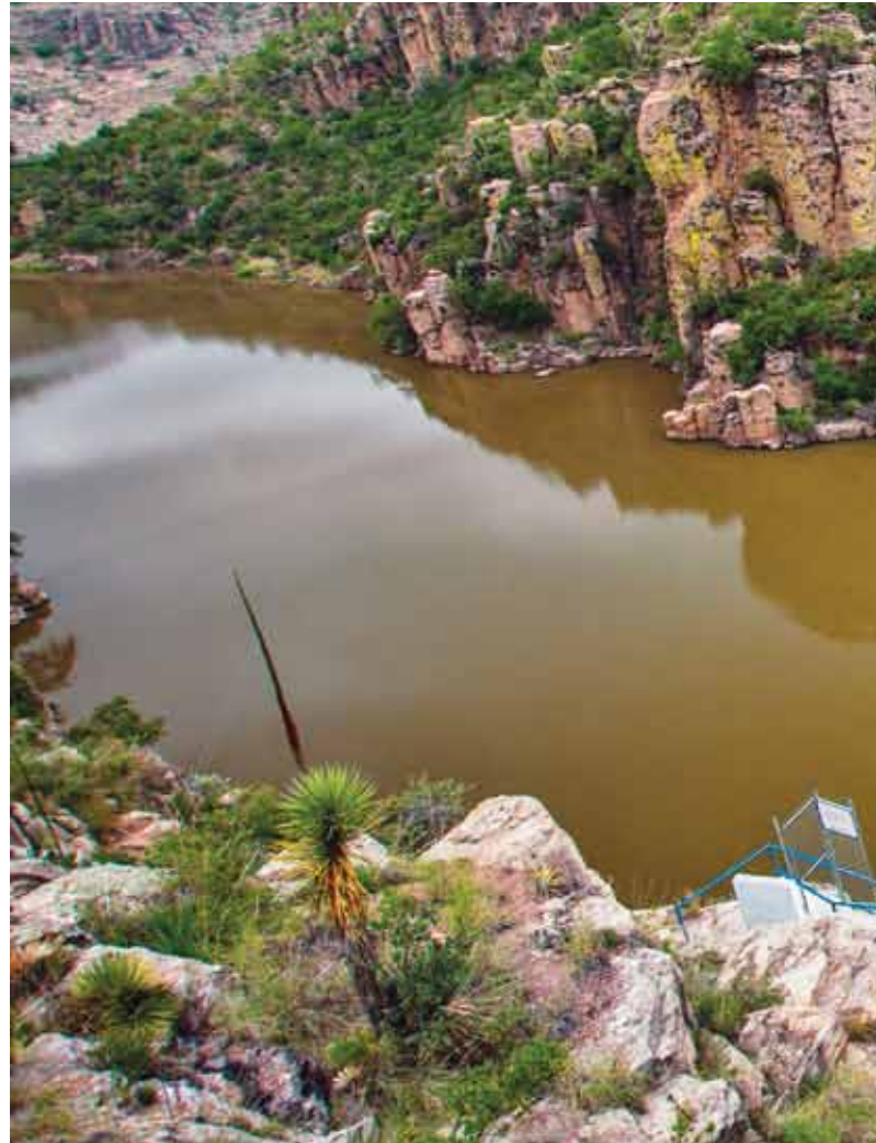
Presas Potrerillos, Aguascalientes.
