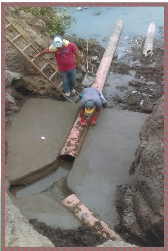
damente 1 kilómetro y ahora completándola con el colector dando la salida a este drenaje hacia la Planta Tratadora de Aguas Residuales, con esto se evitara la contaminación a los cuerpos de agua y mantos freáticos por las descargas sanitarias generadas con anterioridad por los vecinos aledaños al canal.
