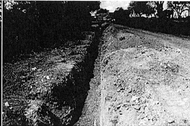
Excavación de Cepa del Punto N° 4 AL Punto N° 12
