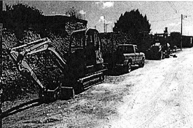
Maquinaria en Obra y Vehiculo para Apoyo de Obra.
