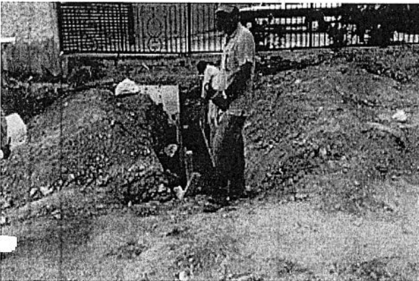
Descimbra del encofrado punto N° 43 al N° 44
