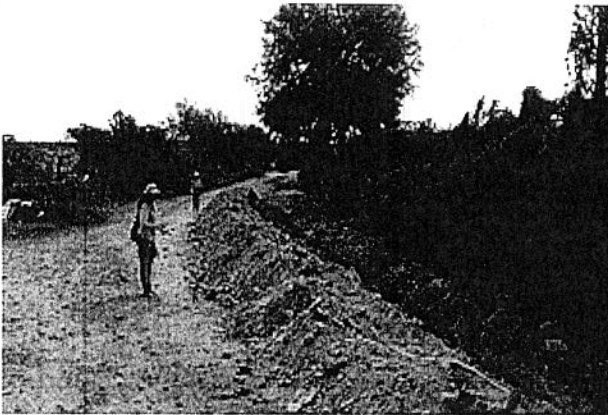
Excavación de Cepa del Punto N° 3 AL Punto N° 4.
